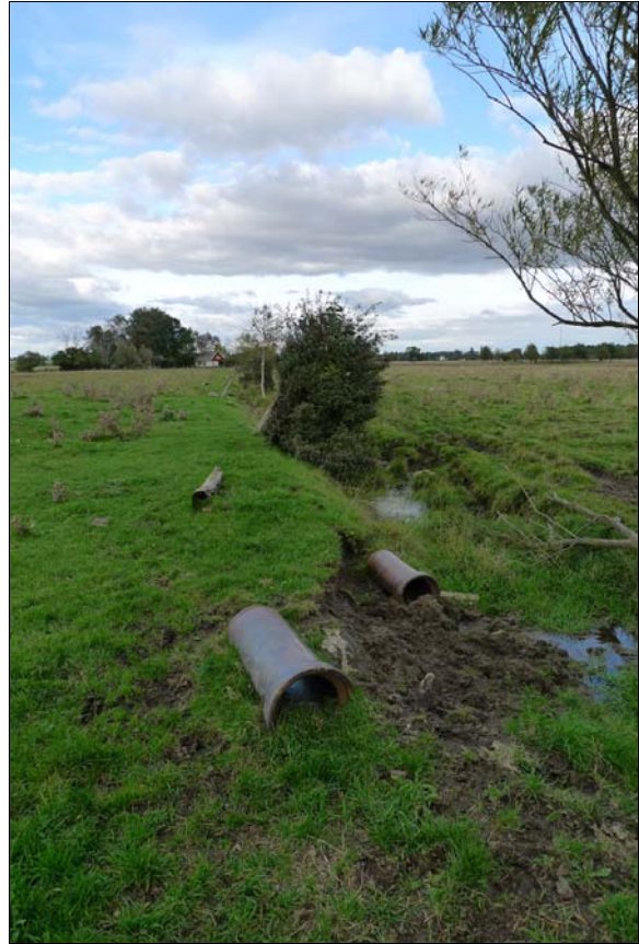
Fig. 15. Höganäsrör vid den nordligaste avrinningskanalen. Rören är gjorda av stengods, saltglaserade och inte genomsläppliga för vatten. De fungerar därför inte som dräneringsrör men kan ligga i dräneringens stamledning.
